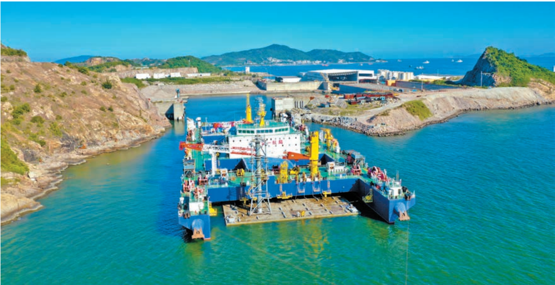
沉管浮運安裝一體船正提帶E19管節前往隧址。 盧志華 攝
