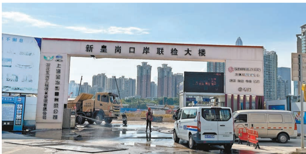
正在建設中的新皇崗口岸聯檢大樓。記者 朱輝豪攝
